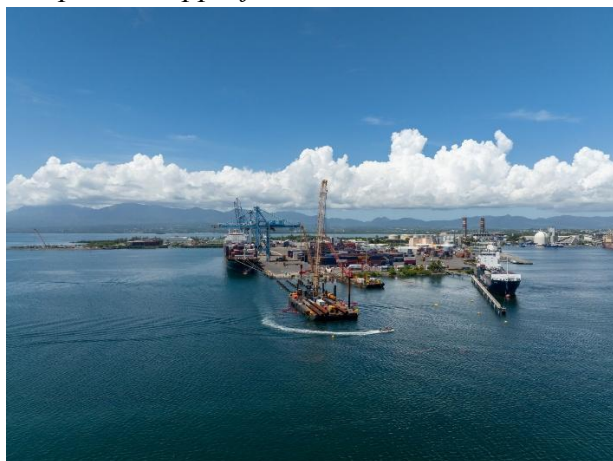
Port de Jarry - Travaux d'extension du quai 12
