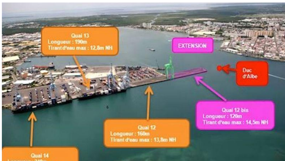
Extension du quai 12 en rose à l'image . ©GPMG
