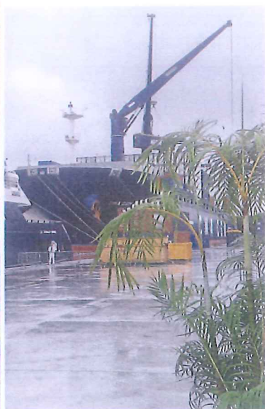
Deux grues sont attendues d'ici 2021. D'une capacité de 51 t à 35 m, elles vont permettre d'augmenter les cadences et d'éviter la saturation des quais.
